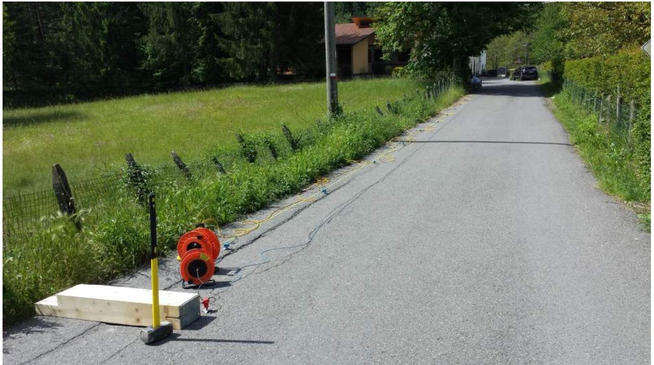
Sismica a rifrazione in onde P e SH: stendimento geofoni SR1
